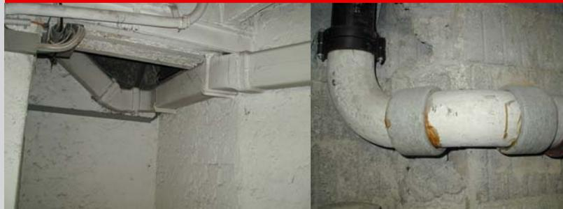
**Utilisation:** conduites d'écoulement d'eau, gaines de ventilation
